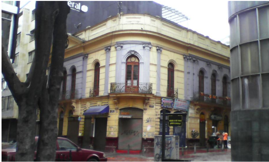
Figura 15. Posible fachada de la pensión de la calle del Florían. Ubicada al frente del Banco Agrario.
