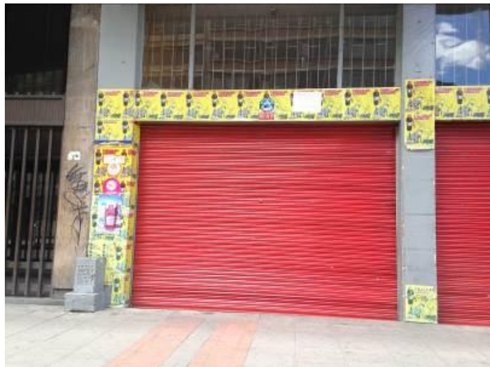
Figura 11. Fachada pensión Eliécer Torres
