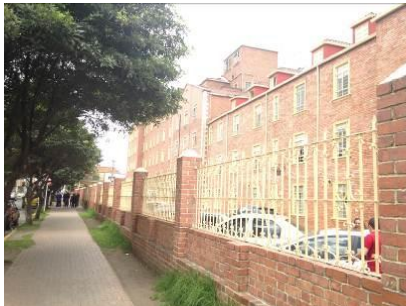
Figura 42. Fachada de la Clínica Palermo
