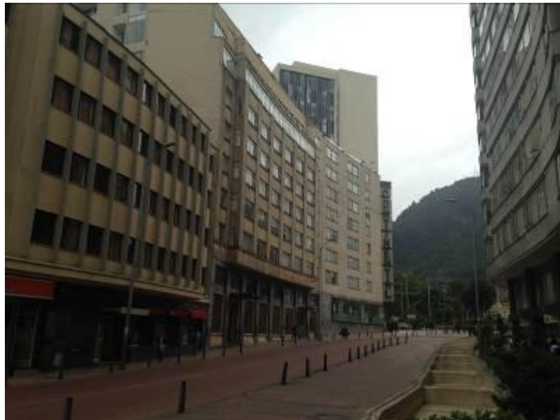
Figura 30. Fachada actual del Hotel Continental.
