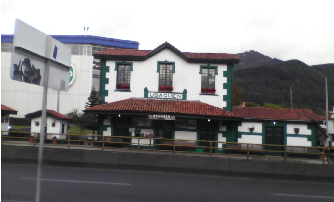
Figura 47. Fachada Estación del Ferrocarril de la Sabana: La Caro
