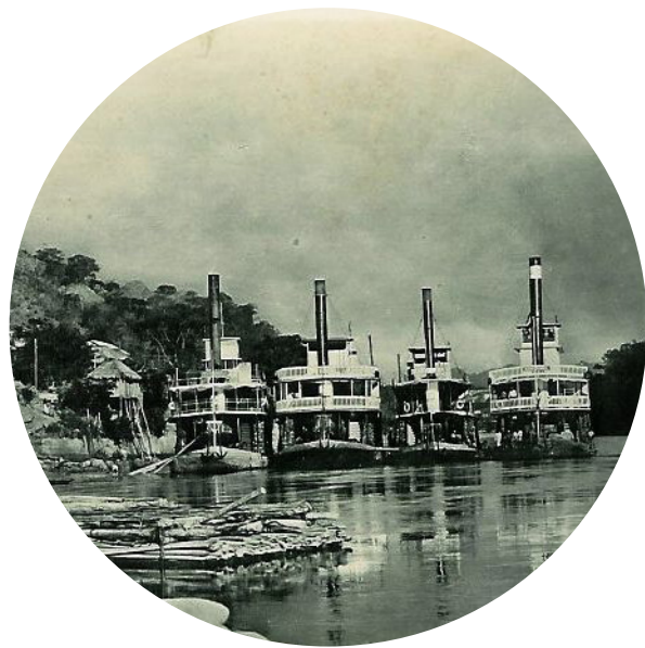
“Puerto de Arrancaplumas” Mediados de los 50's
